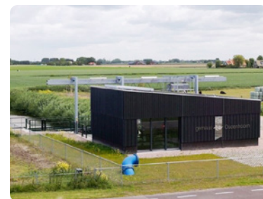
Gemaal Oudenhoorn aan de Zeedijk op Voorne-Putten werd vorig jaar duurzaam gemaakt door o.m. dieselpompen te vervangen door elektrische pompen.
