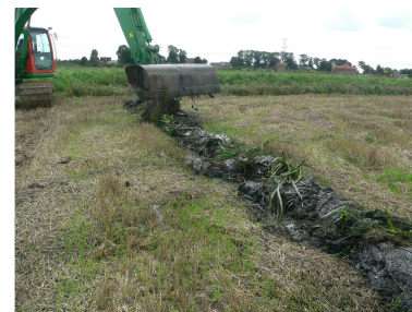
Baggerslib op het land
