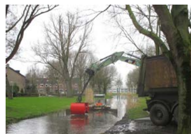
Baggeren in stedelijk gebied
