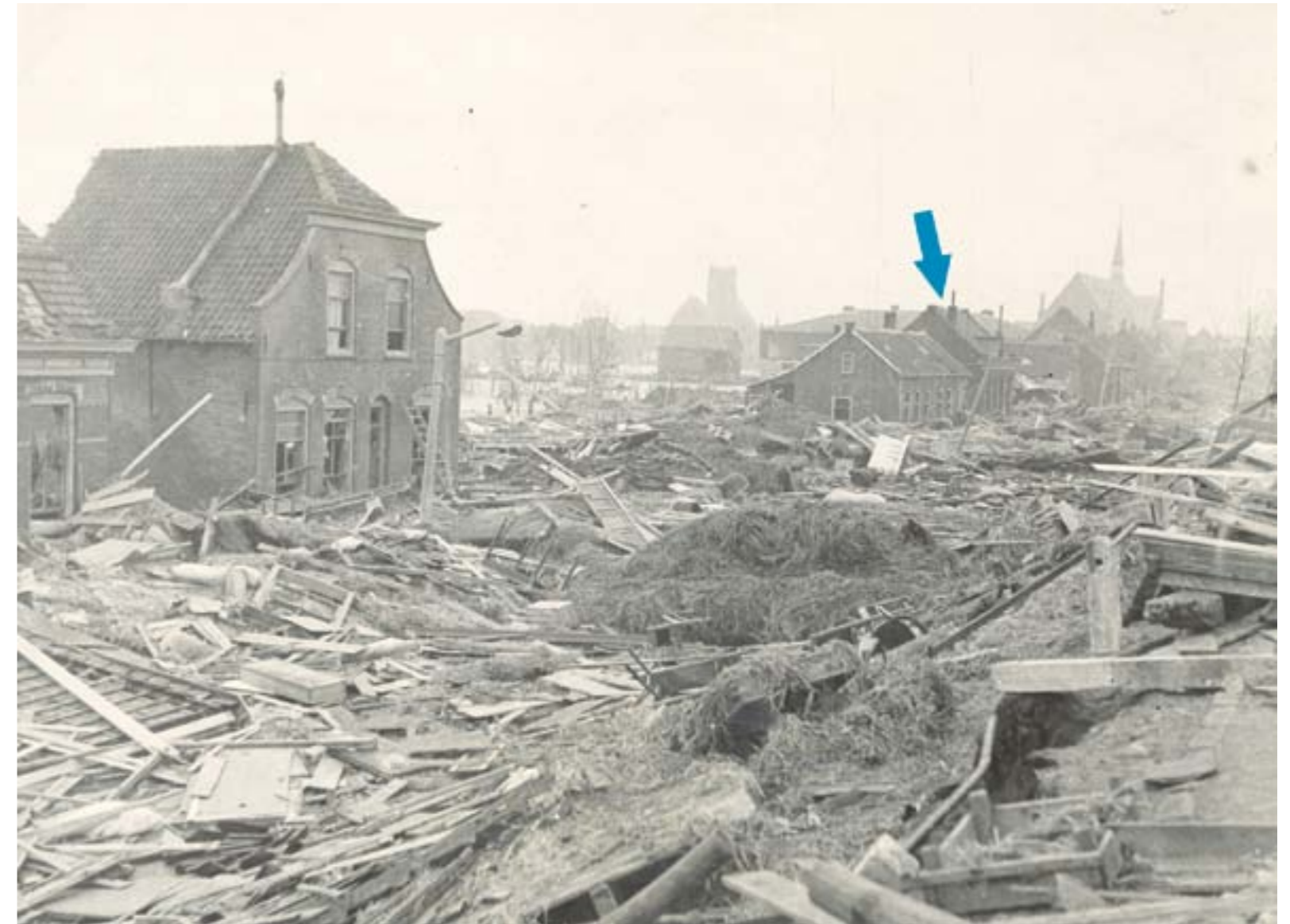
Het huis waarin Frans Pollemans de rampnacht beleefde (aangegeven met de pijl) bleef overeind terwijl veel andere huizen in de straat zijn ingestort.
