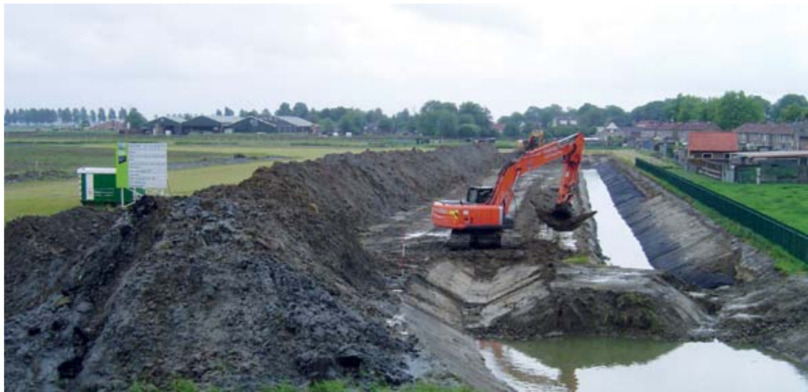
Het laatst afgeronde project is de Nieuwe Stadse Zeedijk bij Stad aan 't Haringvliet
